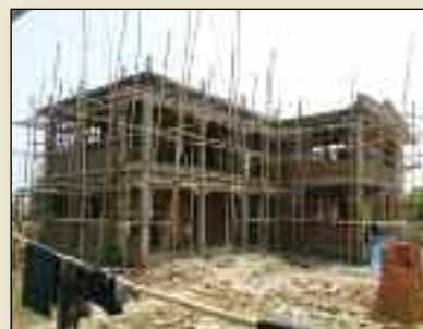
Klinikken er under oppføring.
